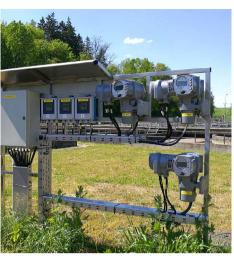
Während AUMA Regelantriebe SAR 07.6 in der Kläranlage Łyna in einem Schacht unter der Erde installiert sind, wurden die zugehörigen Stellantriebs-Steuerungen AC 01.2 gut zugänglich oberirdisch montiert.
